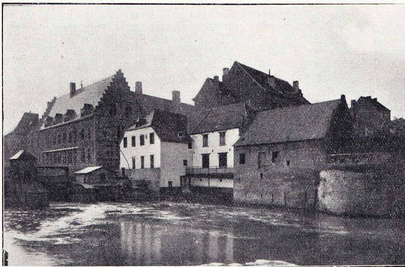
Moulin à eau à Lessines
